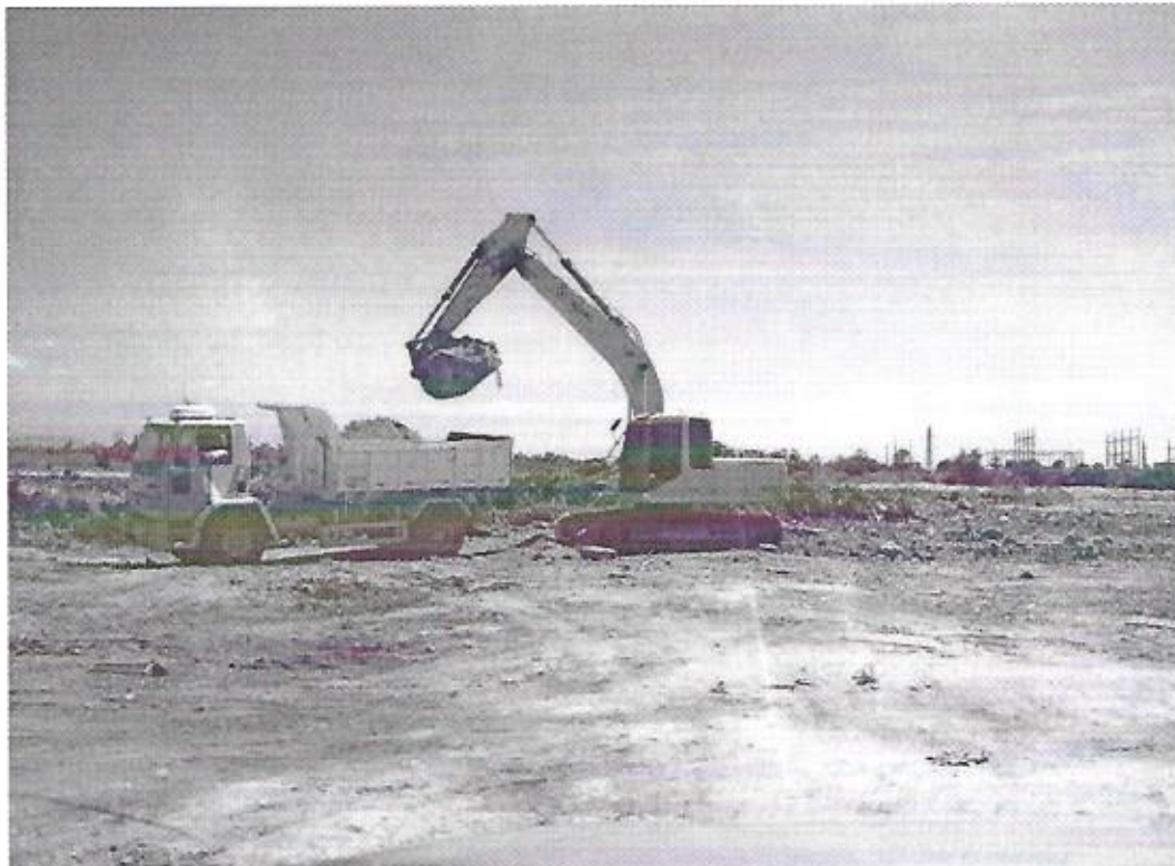
Figura 8.2 - Área de Disposição Final de Resíduos de Podas de Árvores e Varrição e Retirada de Material de Cobertura - ASML - Aquiraz-CE
