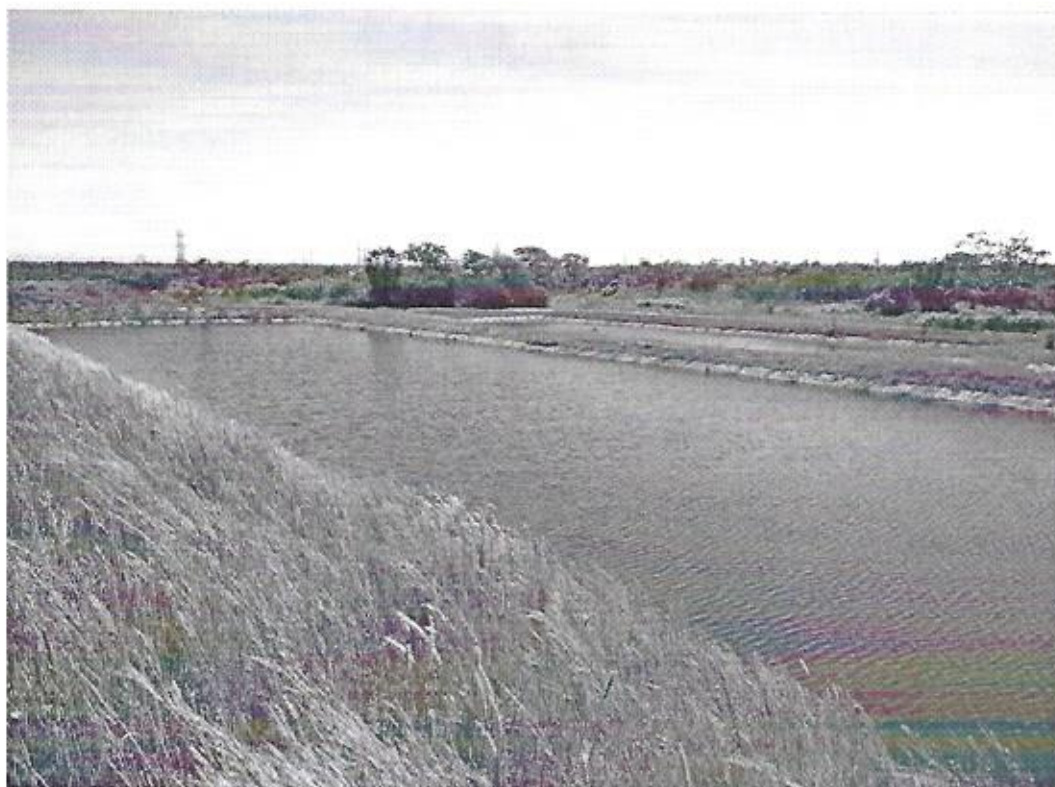
Figura 8.7 - Lagoas de Decantação de Líquidos Lixiviados (Chorume) - ASML - Aquiraz-CE
