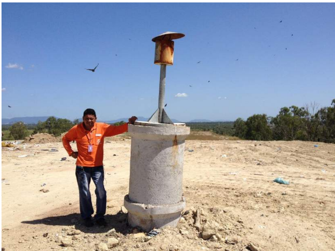
Figura 8.3 - Dreno Passivo de Gases Provenientes da Decomposição dos RSU - ASML - Aquiraz-CE
