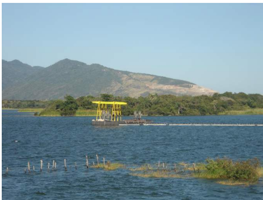
Figura 7.4 – Vista da captação no Açude Gavião.
