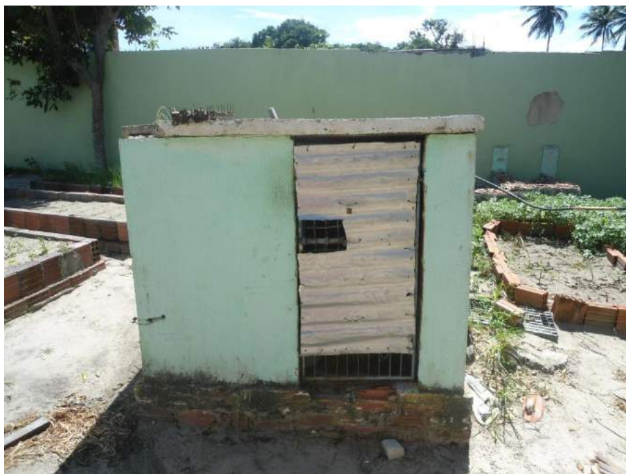
Figura 7.37 – Vista do poço no bairro Olho D'Água.
