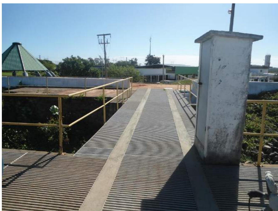
Figura 7.6 – Vista da captação no Açude Gavião.
