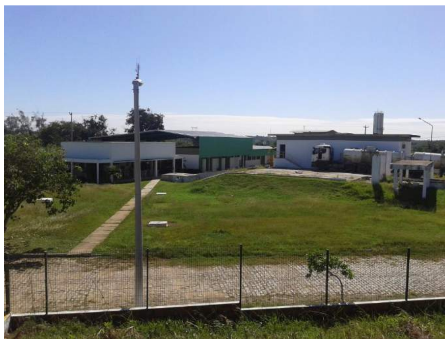
Figura 7.10 – Vista geral da estação de tratamento de água (ETA).
