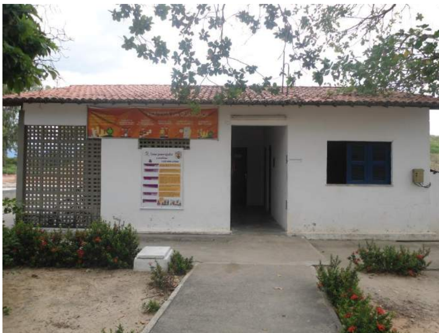
Figura 7.116 – Administração do Aterro Sanitário Metropolitano Leste (ASML).
