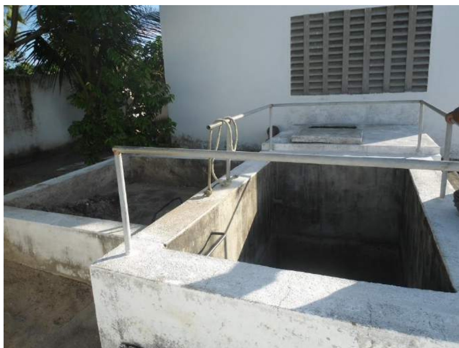
Figura 7.74 – Vista do poço de sucção da estação elevatória EEE-09 (Rua Santo Antônio – Bairro Parque Havaí) do sistema de esgotamento sanitário do Eusébio/CE.
