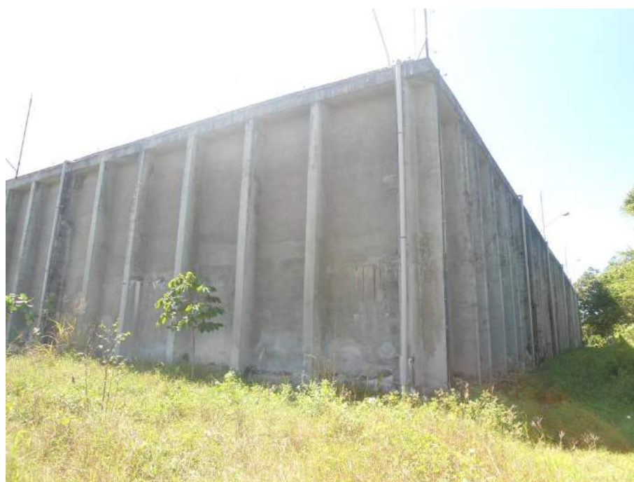
Figura 7.30 – Vista do RAP-Ancuri de 80.000 m 3 .
