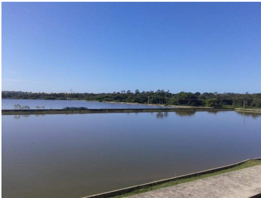
Figura 7.91 – Vista das lagoas de estabilização da ETE do Eusébio/CE, localizada no município de Aquiráz/CE.
