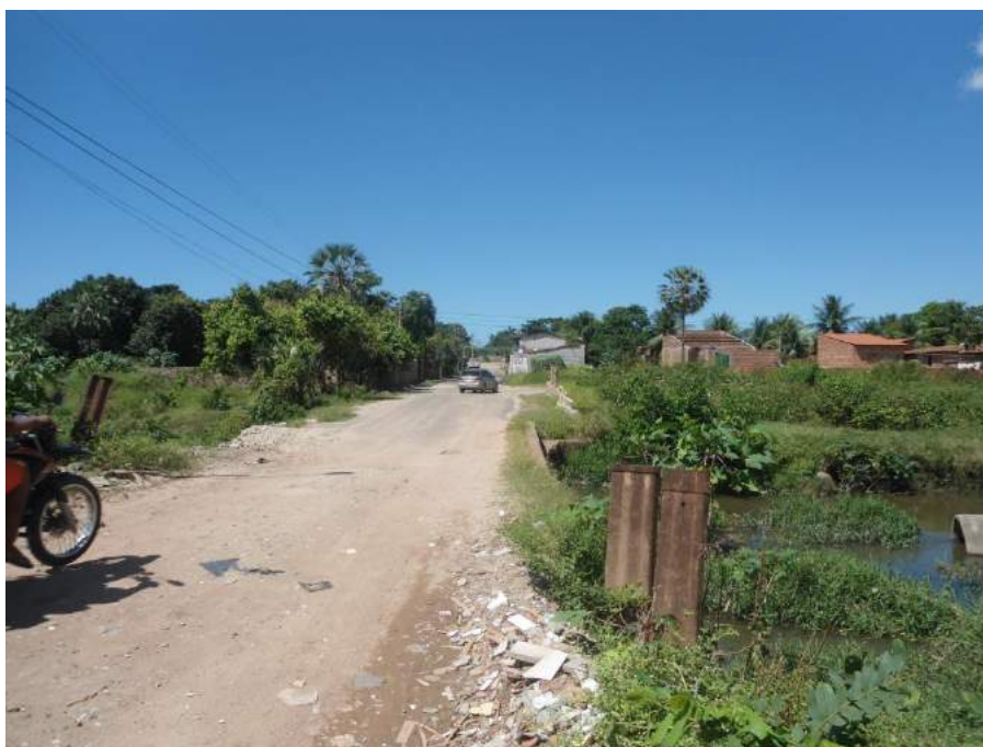
Figura 7.153 – Vista da Ponte à Rua Duarte Coelho em péssimo estado de conservação, havendo alagamentos na área.
