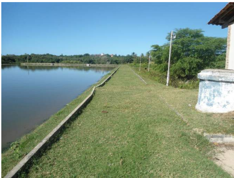
Figura 7.93 – Taludes e coroamento da ETE do Eusébio/CE, localizada no município de Aquiráz/CE.
