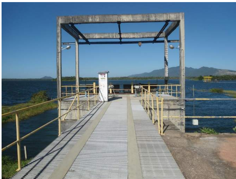
Figura 7.5 – Vista da captação no Açude Gavião.
