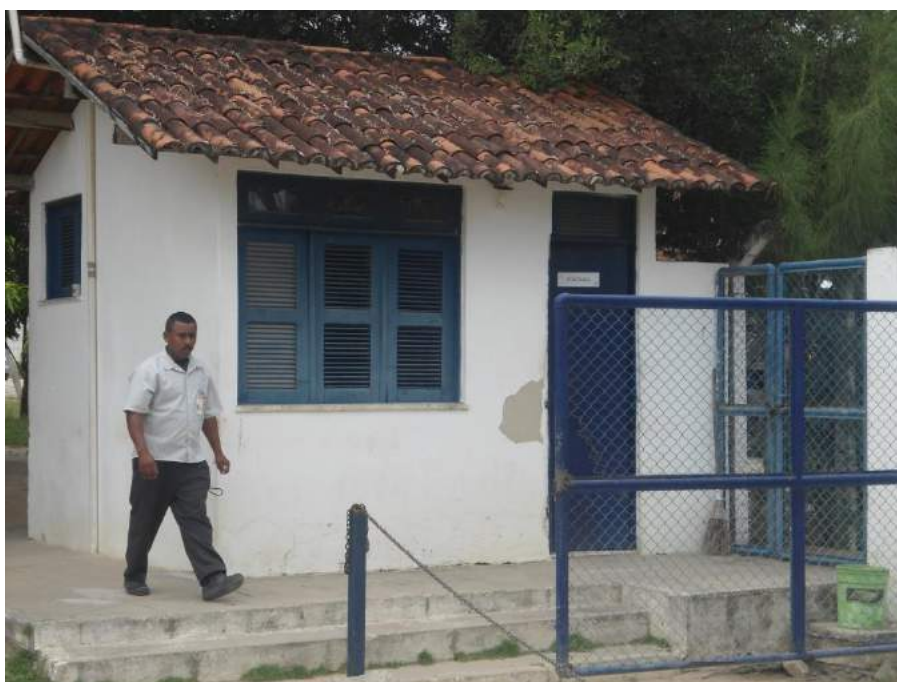
Figura 7.117 – Vigilante da Entrada do Aterro Sanitário Metropolitano Leste (ASML).
