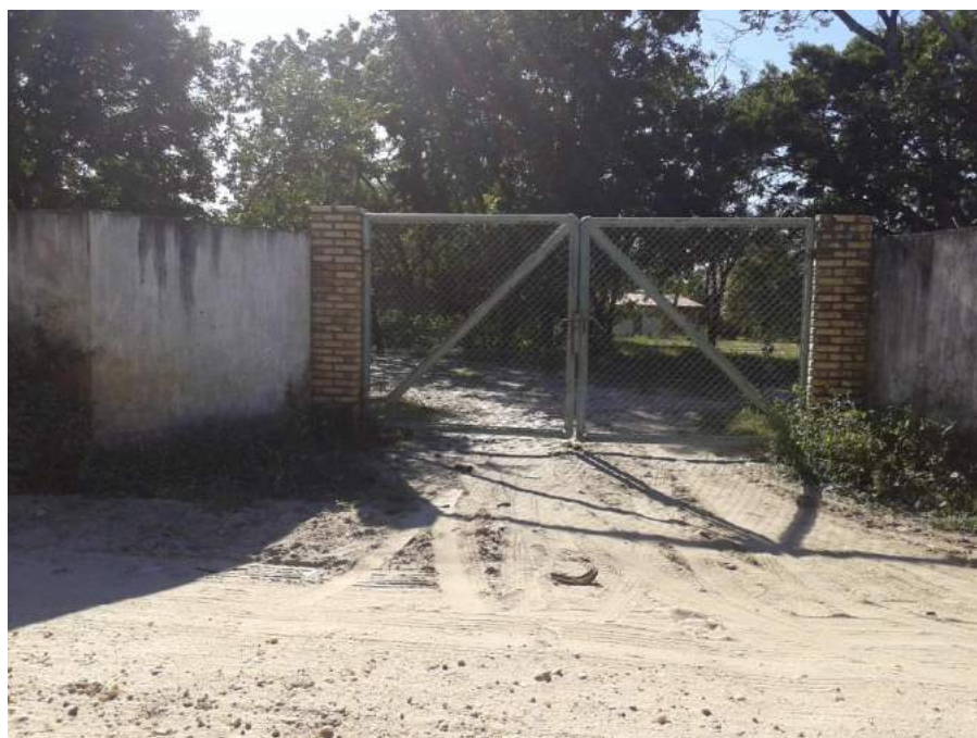
Figura 7.86 – Entrada da ETE do Eusébio/CE, localizada no município de Aquiráz/CE.
