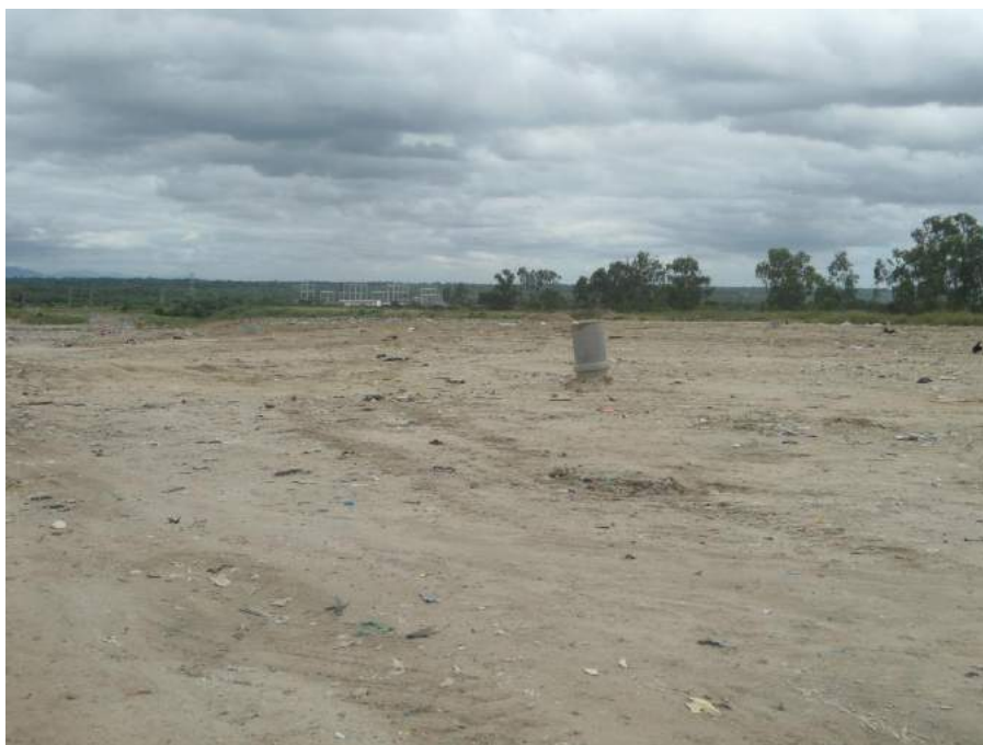
Figura 7.124 – Dreno passivo de gases do Aterro Sanitário Metropolitano Leste (ASML).
