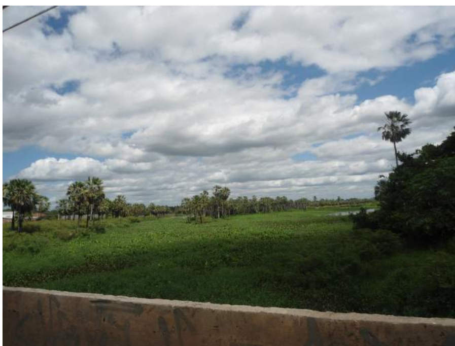
Figura 7.155 – Vista da Ponte à Estrada do Fio, havendo alagamentos na área.
