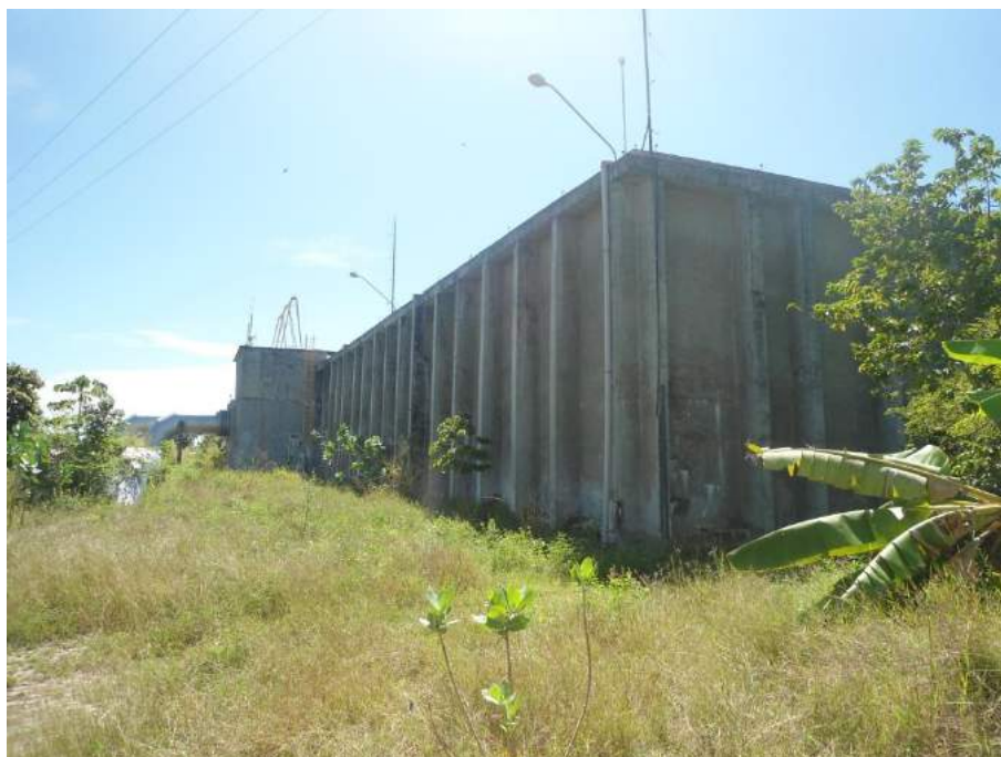
Figura 7.31 – Vista do RAP-Ancuri de 80.000 m 3 .
