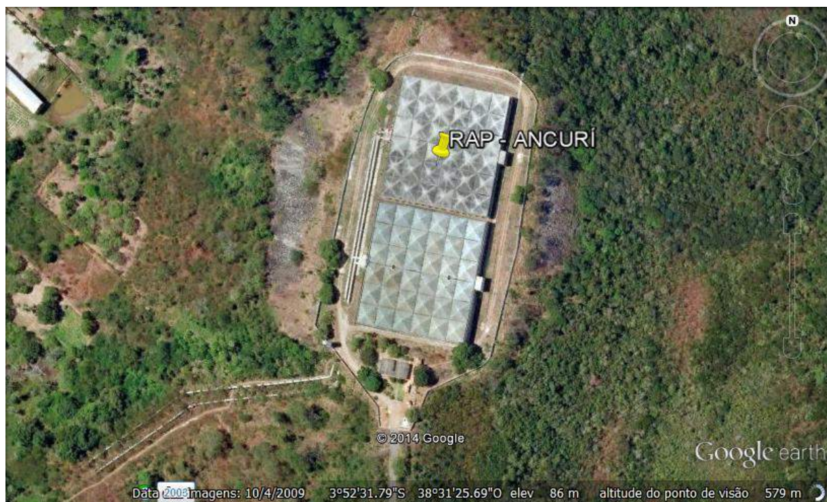
Figura 7.29 – Vista aérea do RAP-Ancuri de 80.000 m 3 .
