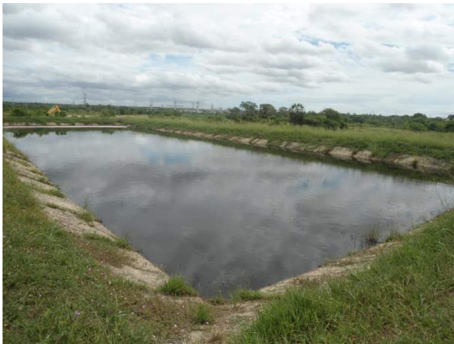
Figura 7.128 – ETE (lagoas) do Aterro Sanitário Metropolitano Leste (ASML).
