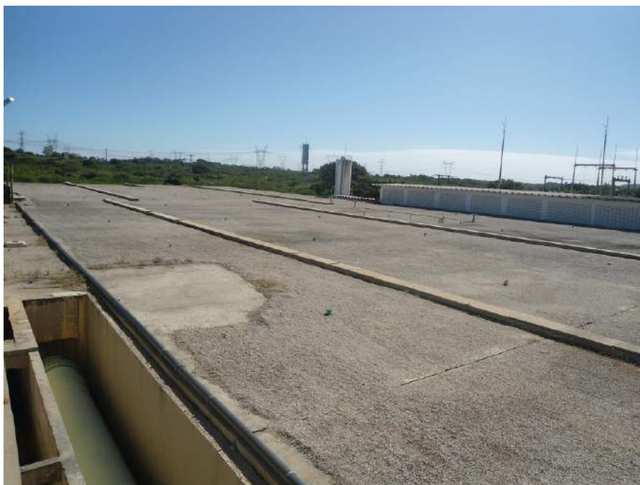
Figura 7.27 – Vista do reservatório semi-enterrado de 35.000 m 3 (RSE).
