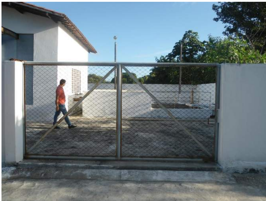
Figura 7.79 – Entrada da estação elevatória EEE-10 (Rua Wilson Milfhon – Bairro Alagoinha) do sistema de esgotamento sanitário do Eusébio/CE.
