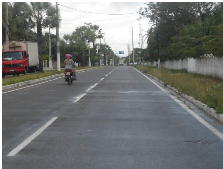
Figura 7.138 – Av. Eusébio de Queiróz – rua asfaltada.
