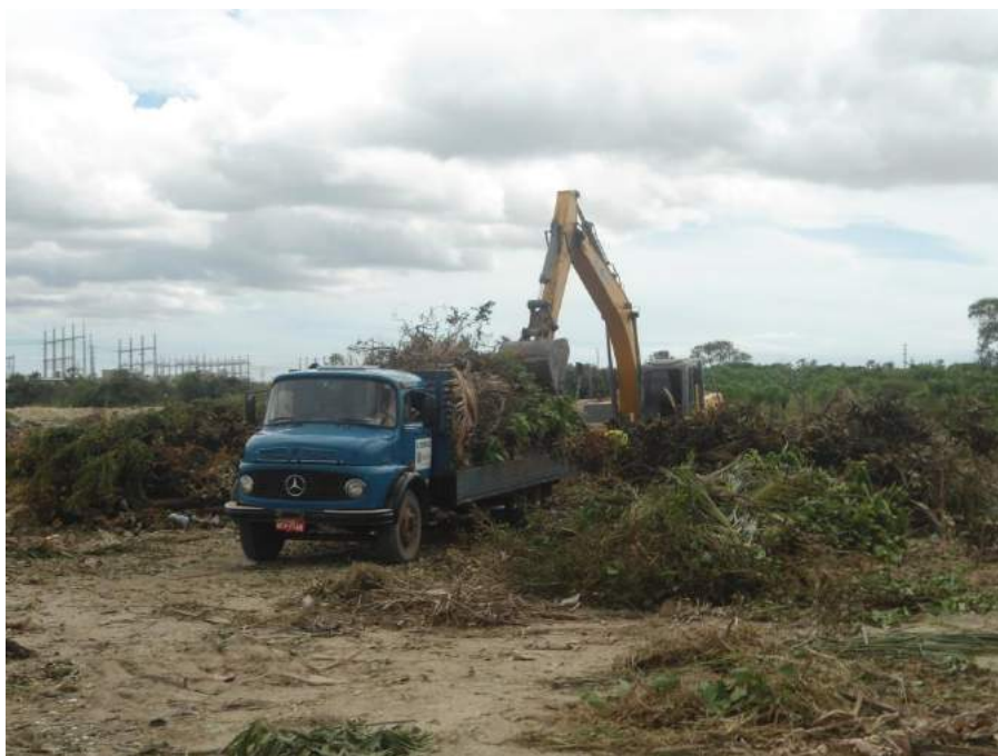
Figura 7.122 – VÁrea de disposição final de resíduos de podas de árvores e varrição do Aterro Sanitário Metropolitano Leste (ASML).
