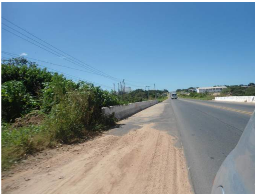
Figura 7.158 – Vista da Ponte sobre o Anel Viário, próximo ao cemitério.
