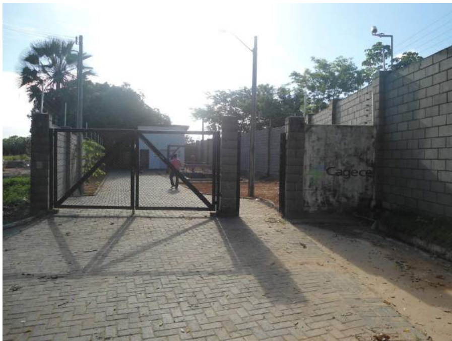
Figura 7.65 – Entrada da estação elevatória EEE-08 (Rua Beira Rio – Condomínio Jardim Ibiza) do sistema de esgotamento sanitário do Eusébio/CE.
