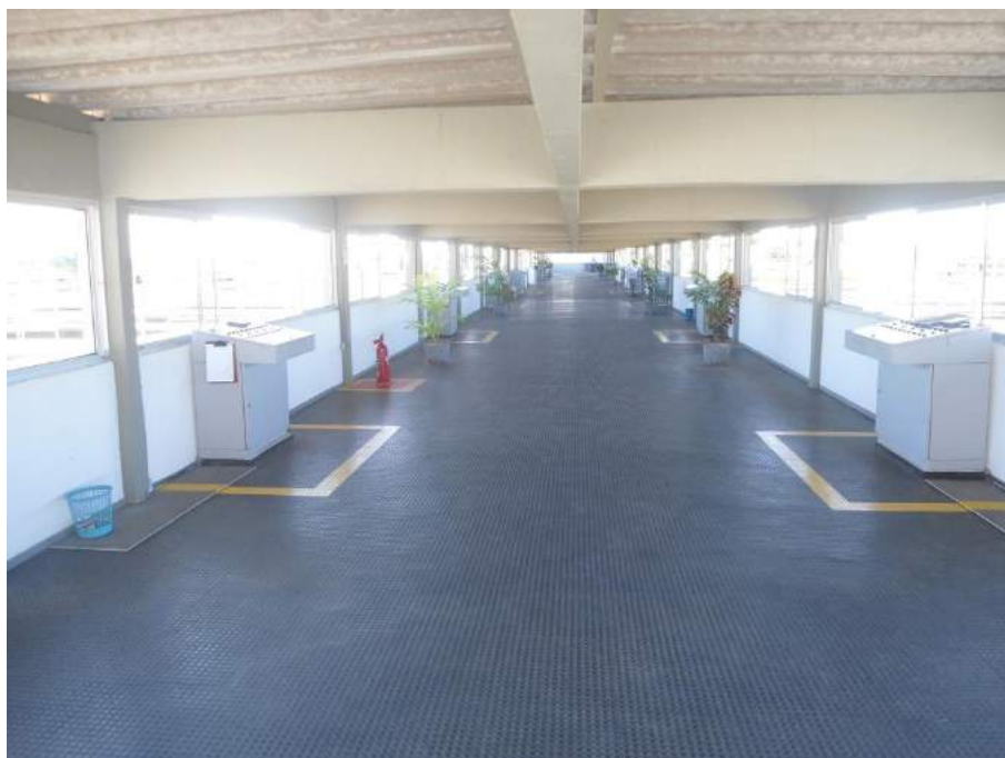
Figura 7.14 – Vista da unidade de filtração da ETA.
