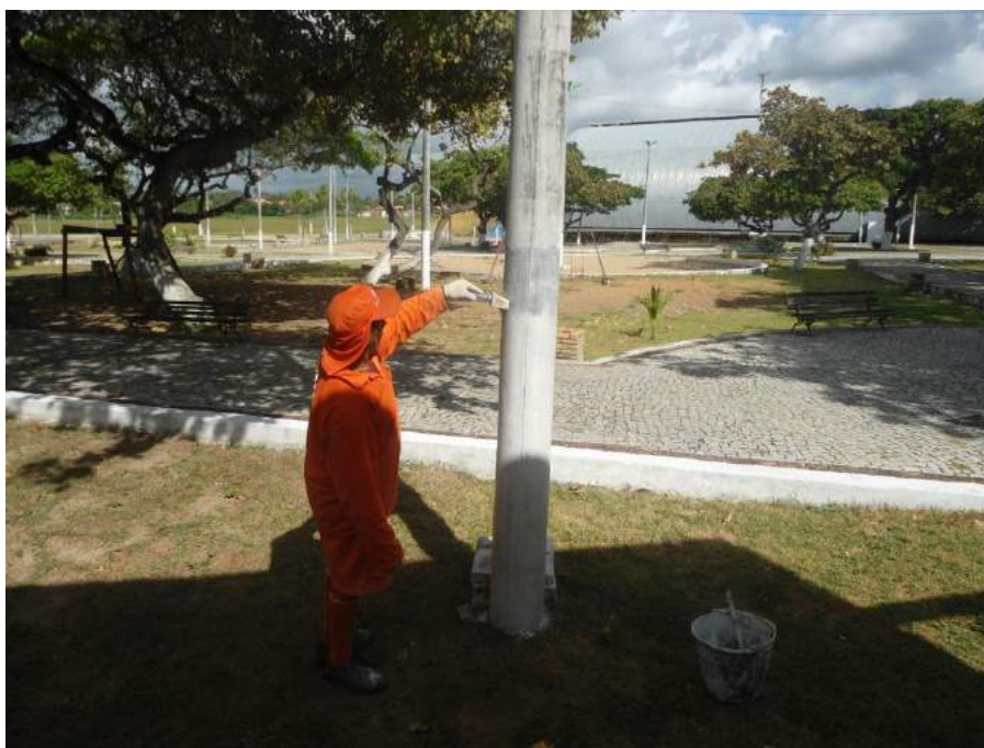
Figura 7.105 – Garis realizando o serviço de pintura de meio-fio/logradouros.
