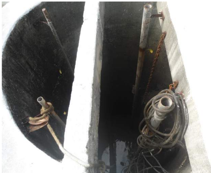
Figura 7.47 – Vista do poço de sucção da estação elevatória EEEE-02 (Rua Acilon Gonçalves – Bairro Guaribas) do sistema de esgotamento sanitário do Eusébio/CE.
