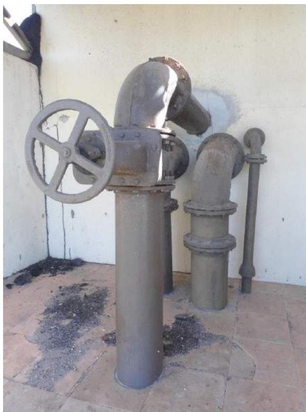
Figura 7.87 – Tubulação de chegada do esgoto do Eusébio e Aquiráz da ETE do Eusébio/CE, localizada no município de Aquiráz/CE.
