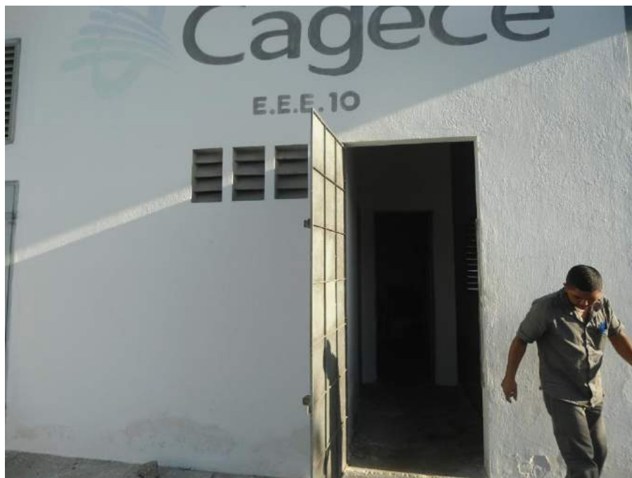
Figura 7.83 – Vista da casa do quadro de comando/bombas da estação elevatória EEE-10 (Rua Wilson Milfhon – Bairro Alagoinha) do sistema de esgotamento sanitário do Eusébio/CE.
