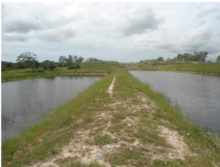
Figura 7.129 – ETE (lagoas) do Aterro Sanitário Metropolitano Leste (ASML).
