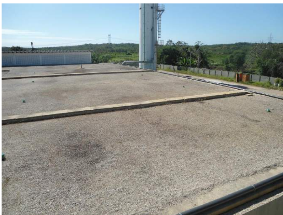
Figura 7.28 – Vista do reservatório semi-enterrado de 35.000 m 3 (RSE).
