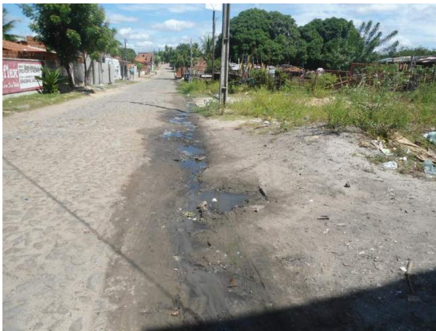
Figura 7.44 – Esgoto a céu aberto.
