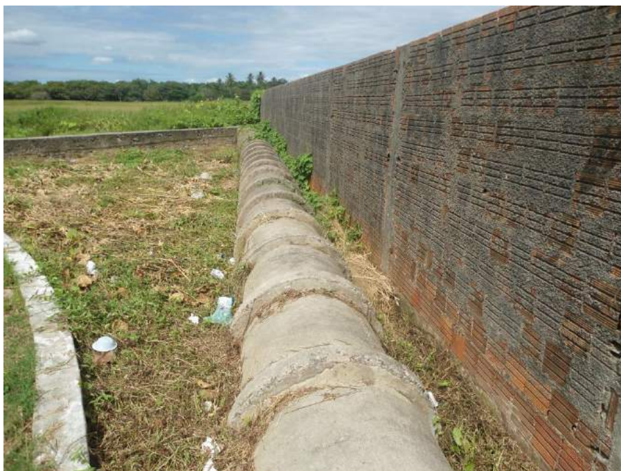
Figura 7.132 – Tubulação de drenagem na Praça do Pólo.
