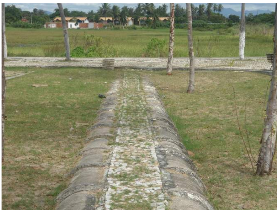
Figura 7.133 – Tubulação de drenagem na Praça do Pólo.
