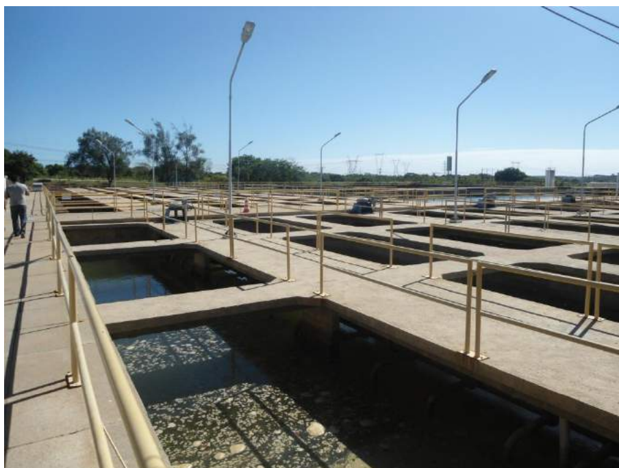
Figura 7.13 – Vista da caixa de passagem (antigo floculador) da ETA.
