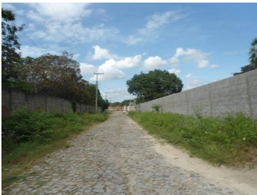
Figura 7.141 – Rua Cel. Libório Gomes Da Silva – rua em pedra tosca.
