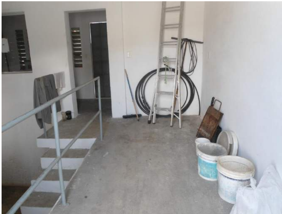
Figura 7.77 – Vista interna da casa do quadro de comando/bombas da estação elevatória EEE-09 (Rua Santo Antônio – Bairro Parque Havaí) do sistema de esgotamento sanitário do Eusébio/CE.
